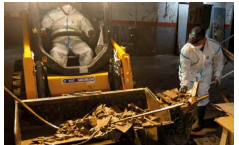
Empresa treballant en l'extracció de llot en un garatge
