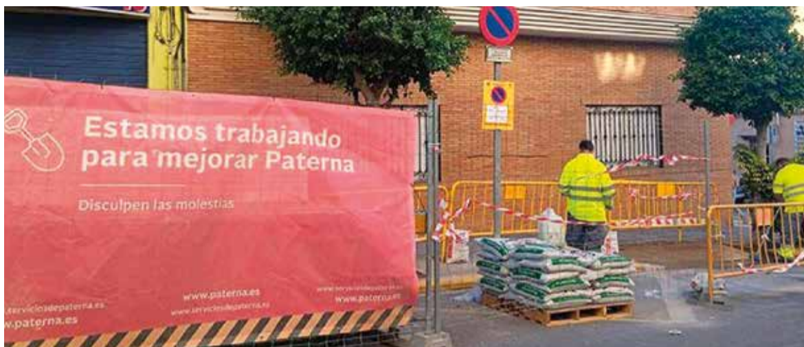
Obres als carrers de Paterna
