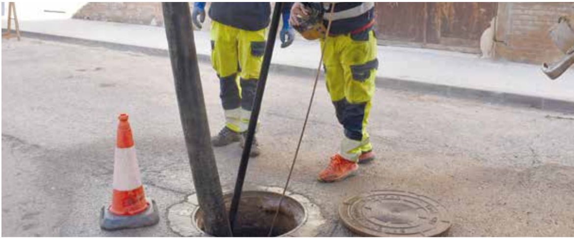
Obres als carrers d'Alfafar
