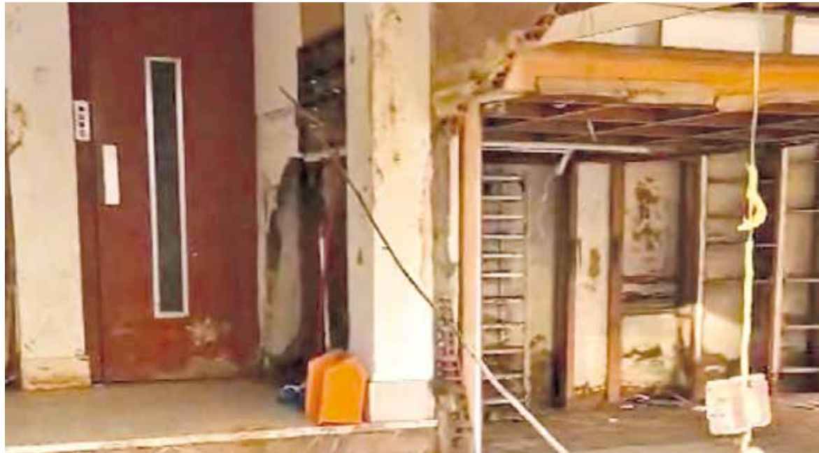
Imatge d'arxiu, pertany a un pati de Paiporta, i va ser presa 5 dies després de la Dana
