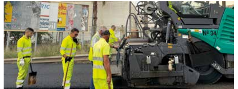
Obres a Alfatar
