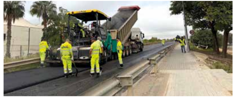
Obres al pont d'Ikea
