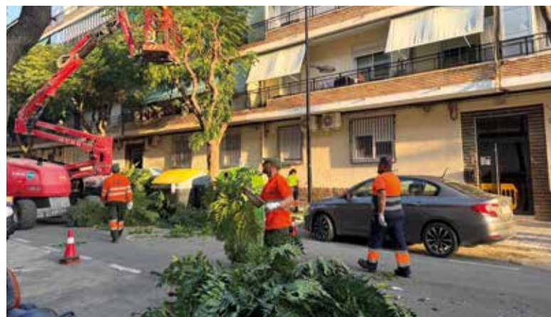
Treballs a la via pública a Alfatar
