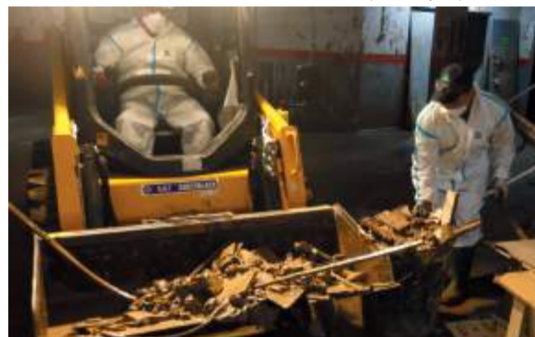
Empresa treballant en l'extracció de llot en un garatge
