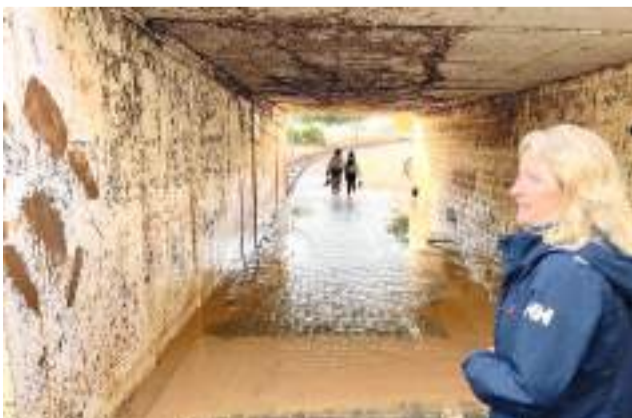
Pas subterrani a Xirivella
