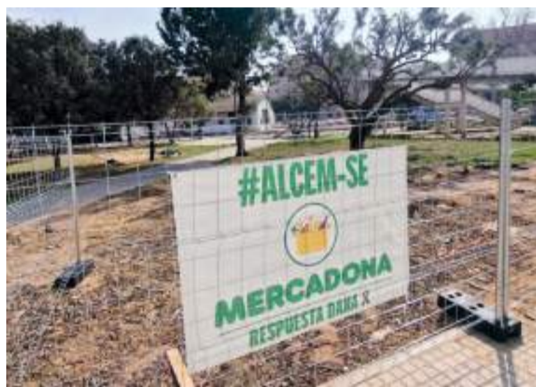
Han començat les obres al parc
