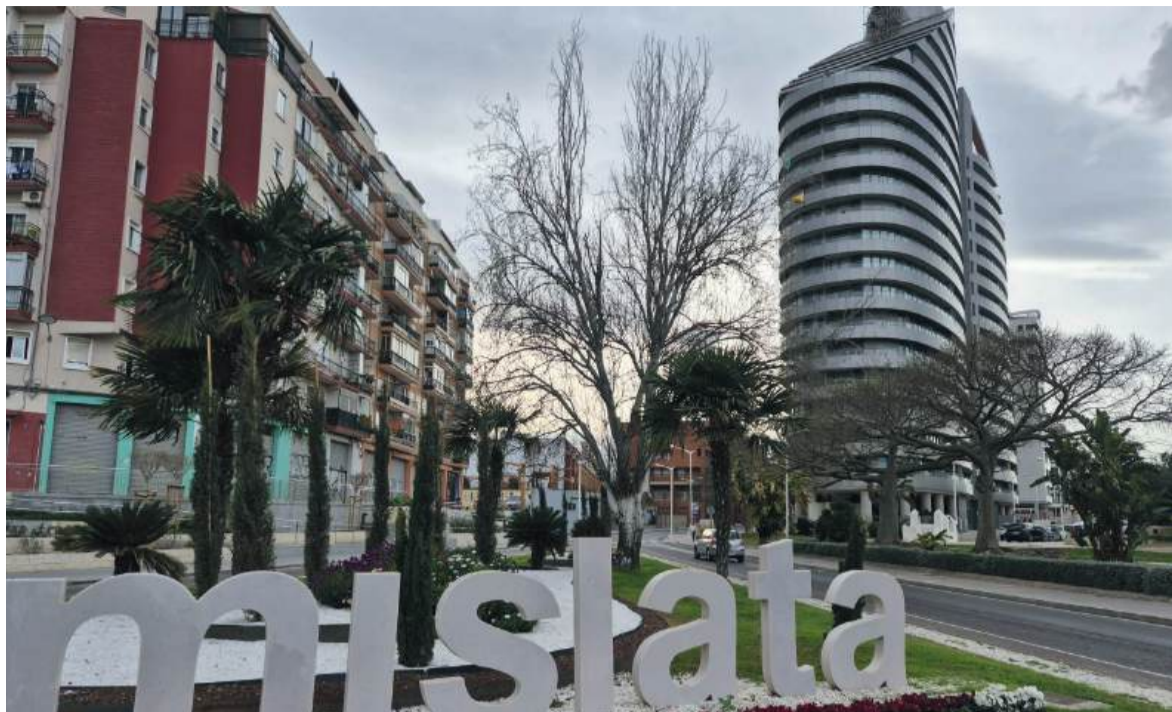
Edifici Navis, front al Parc de Capçalera, terme de Mislata
