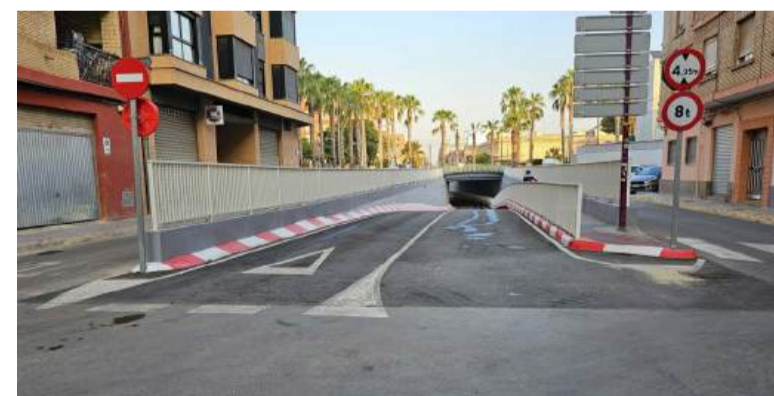
Nou túnel de Alfagar a Benetússer
