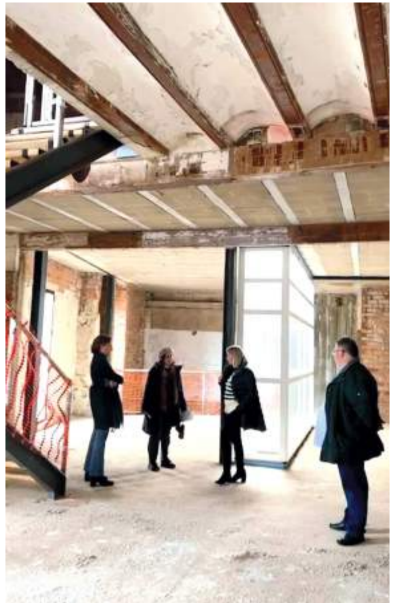
Obres Casa de la Dona
