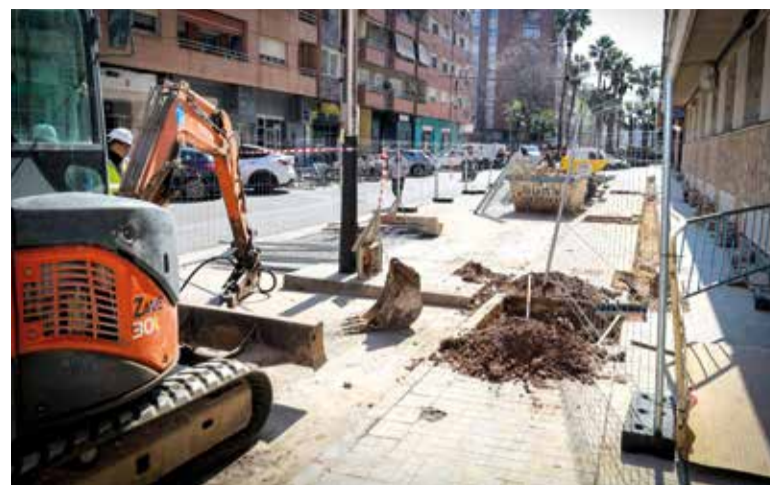
S'han llevat les palmeres que estaven en mal estat
